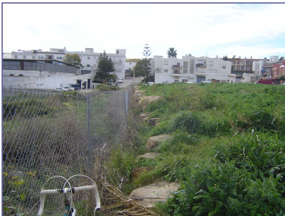
Visual con el estado actual de la linde sur de la parcela, con el muro de escollera
