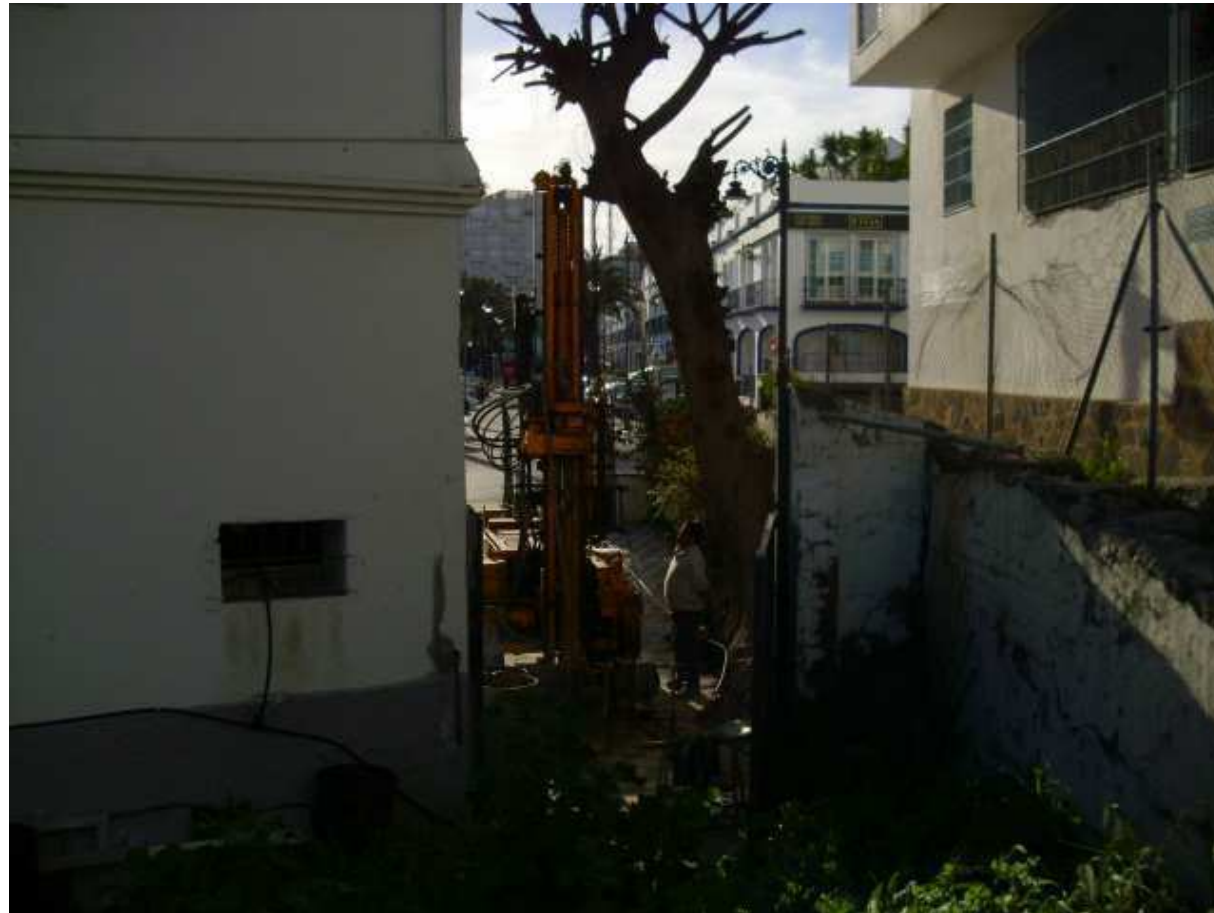
EXP. 13.863 EMPLAZAMIENTO SONDEO ROTATIVO S-1
