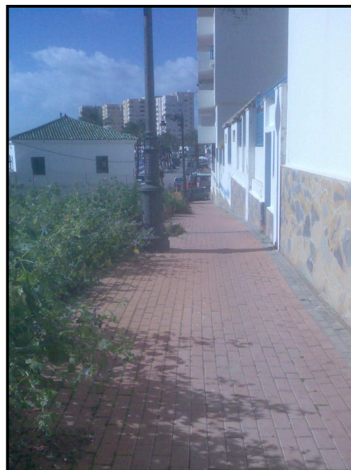
Foto 2 .- Acera existente en el entorno del pk 0+00 a 0+040
