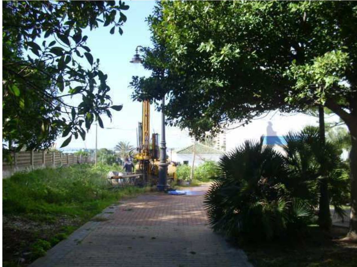
EXP. 13.863 EMPLAZAMIENTO SONDEO ROTATIVO S-2
